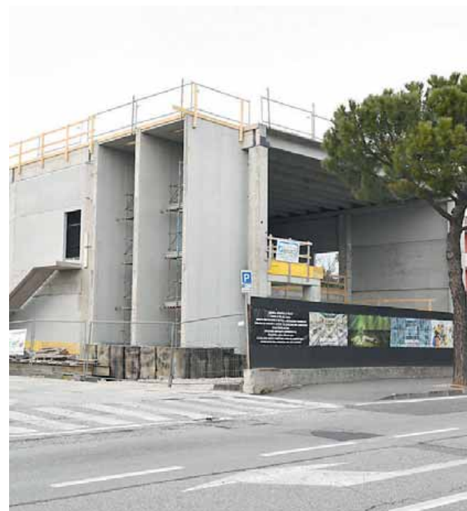
Il supermercato in corso di realizzazione in viale Trento a Riva
