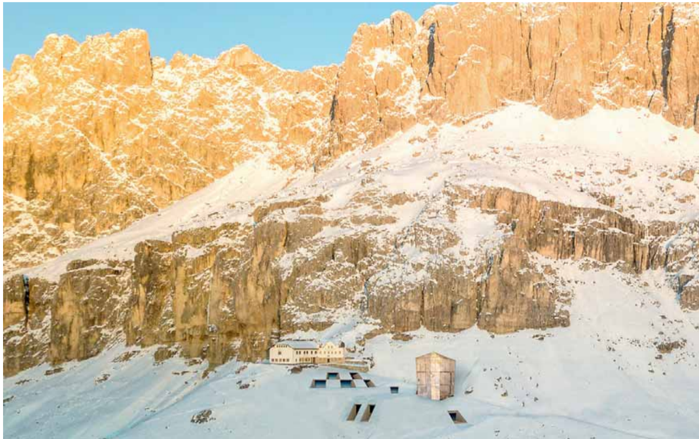
Rendering del progetto della nuova stazione di arrivo della cabinovia del Coronelle, con tutta la meccanica interrata e la torre panoramica in cristallo
