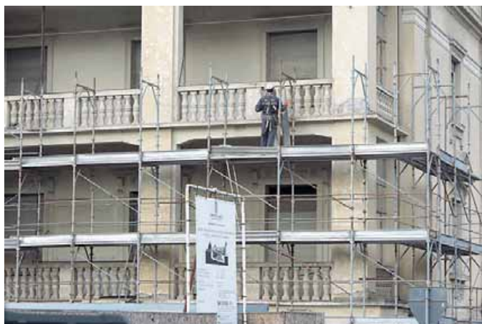
Sono inviati i lavori di messa in sicurezza delle logge del Quisisana (f. Galas)
