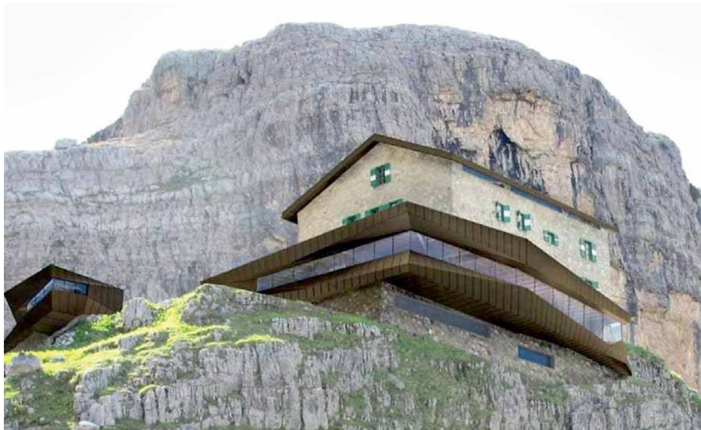
• Il rendering della nuova terrazza panoramica attaccata al rifugio Brentei: l'abbinata antico-moderno non è molto piaciuta
