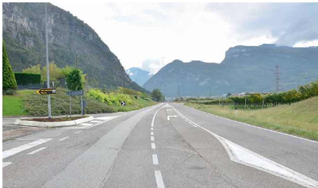
• L'area a sud di Marco, dove sarebbe previsto lo sbocco della A31 della Valdastico
