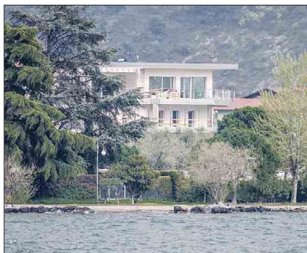
L'edificio e il piano rialzato, visti dalla passeggiata del Brione (Salvi)
