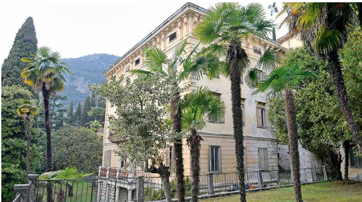
• Primo passo ufficiale del Comune verso la trasformazione dell'ex sanatorio Sanaclero in una struttura ricettiva di alta qualità
