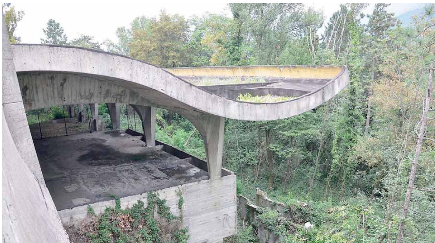
• La particolare struttura ad onda della parte del complesso che si ipotizzava di mantenere: a questo punto sarà demolito per intero (FOTO FESTI)
