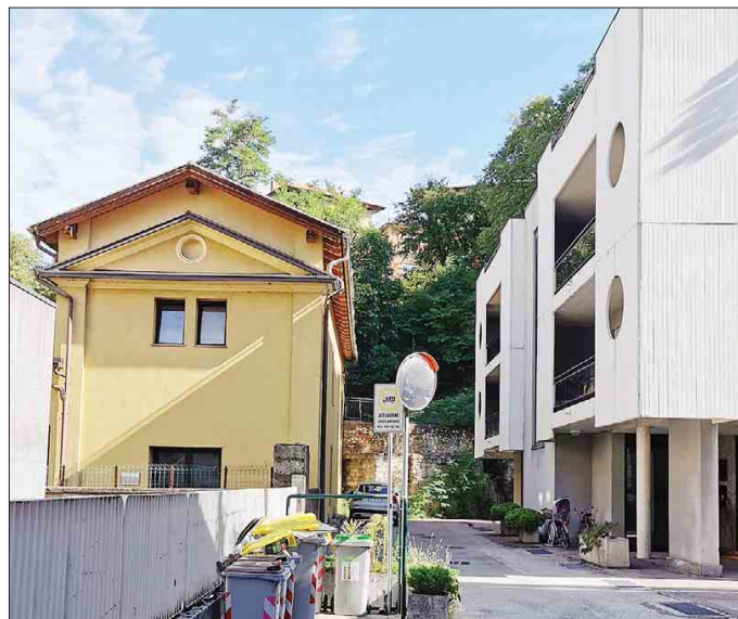
A sinistra, la casetta gialla al 3 di via Grazioli dove è prevista la costruzione di una palazzina alta quasi 20 metri
