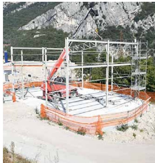
• La mega struttura che fungerà da officina
