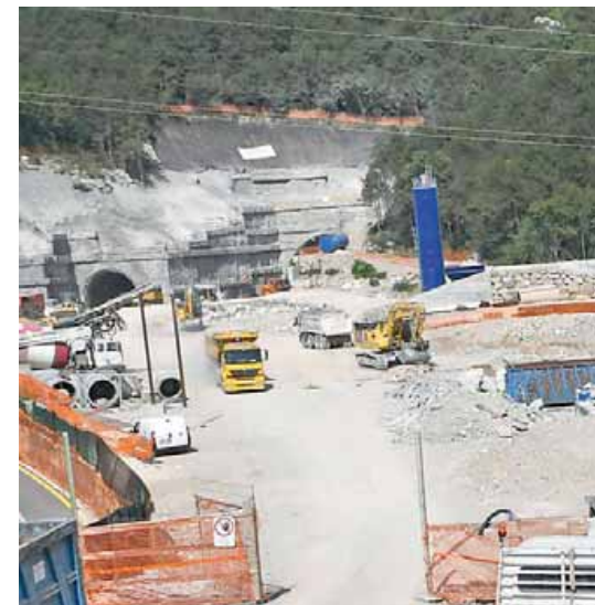
• Già visibili il tunnel viario e quello di servizio
