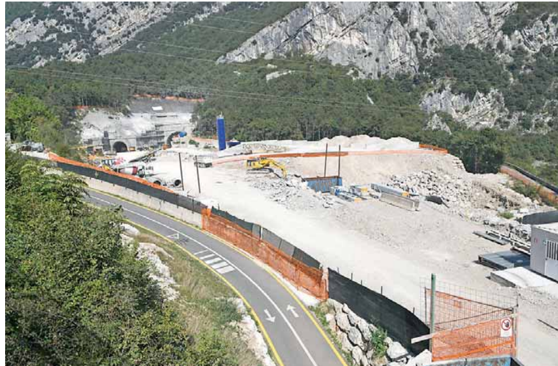
• L'area occupata dal cantiere a Nago è davvero imponente FOTO GALAS
