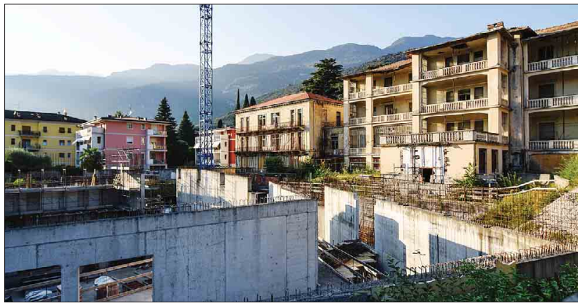
Nella foto di Stefano Salvi il "tormentato" cantiere dell'ex Quisisana. A breve si dovrebbe ripartire con i lavori grazie alla «Inco srl»
