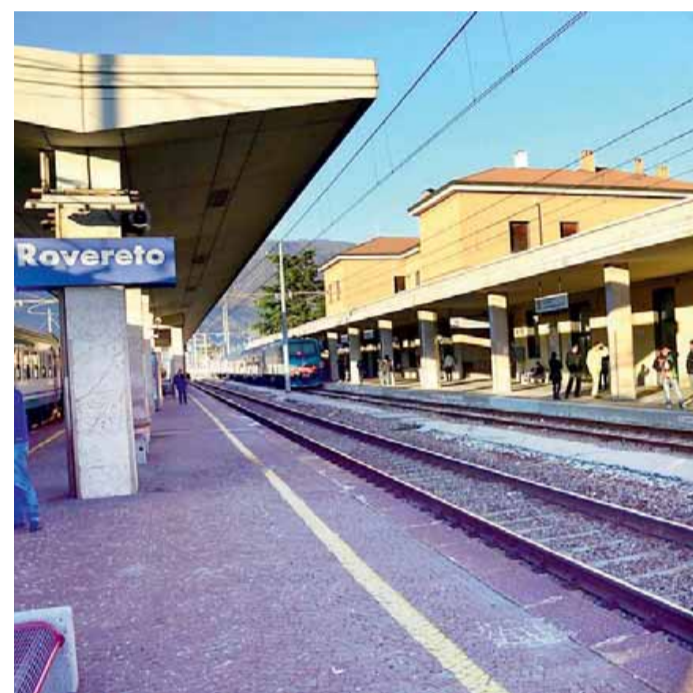
• Torna il sogno della ferrovia Rovereto-Riva
