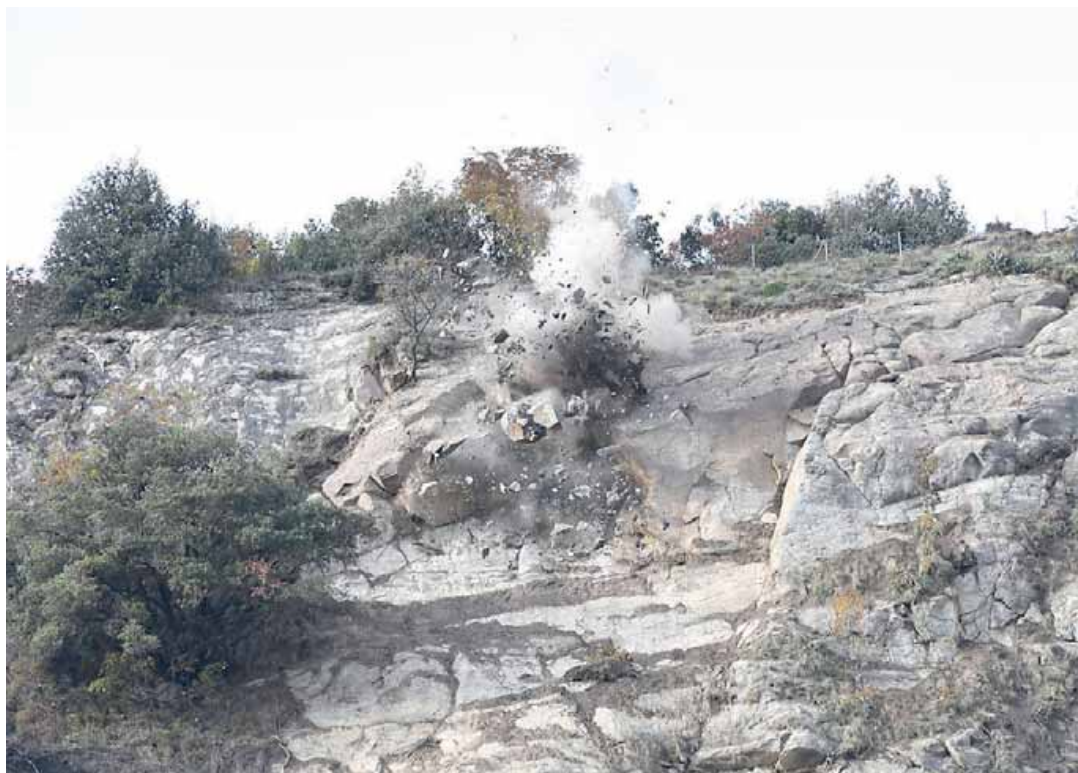
• Il momento in cui l'esplosivo sbriciola la roccia pericolante FOTO GALAS
