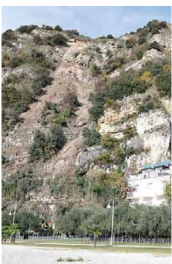
• La frana sopra l'hotel Baia Azzurra
