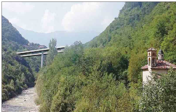
Un nuovo viadotto a Ca' Bianca: l'immagine simbolo del progetto della nuova Valdastico con uscita a Rovereto
