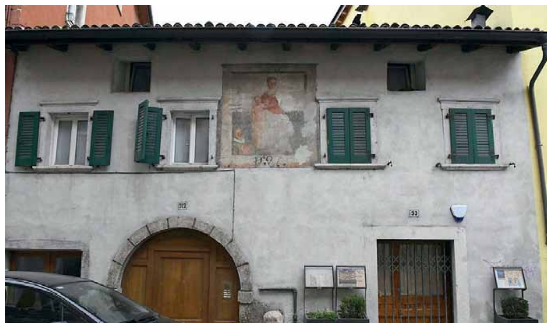
• L'edificio che dà dimora all'Affresco Votivo: la comunità di San Martino lo vuole restaurare
