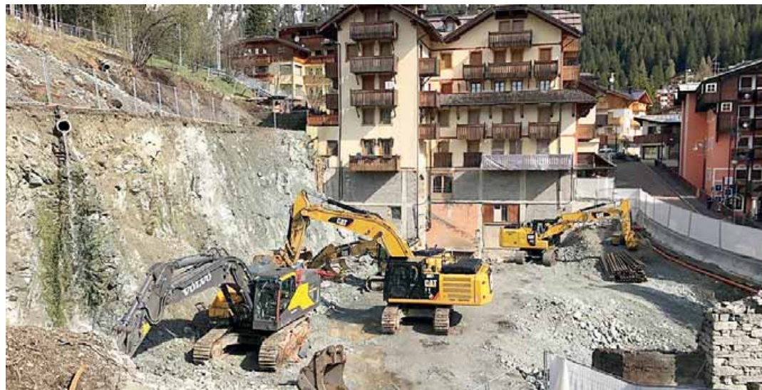
• Scavatori di nuovo operativi nel cantiere dell'ex Hotel Excelsior, a Madonna di Campiglio
