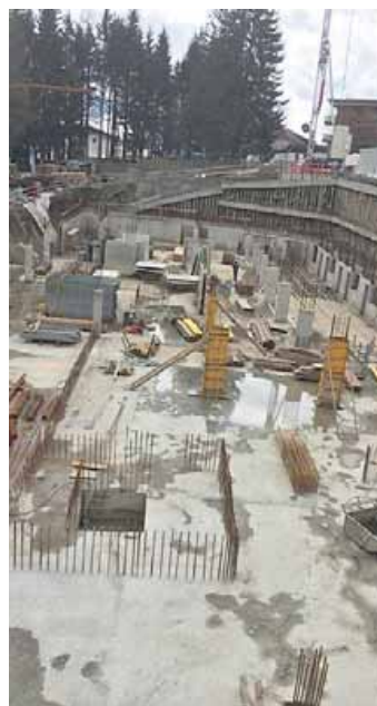
• Lo scavo del cantiere ex Stork
