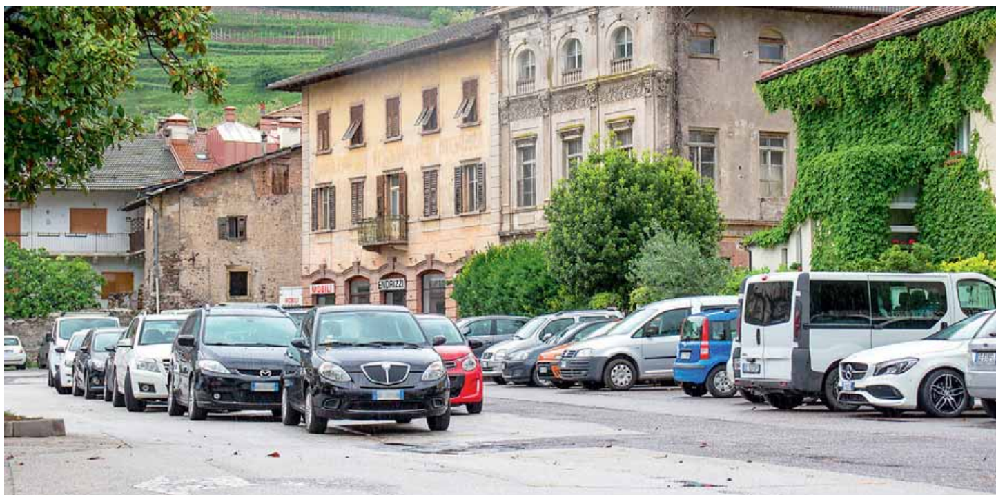
• I lavori per la realizzazione del parcheggio interrato pertinenziale in piazza mercato a Lavis inizieranno lunedì prossimo
