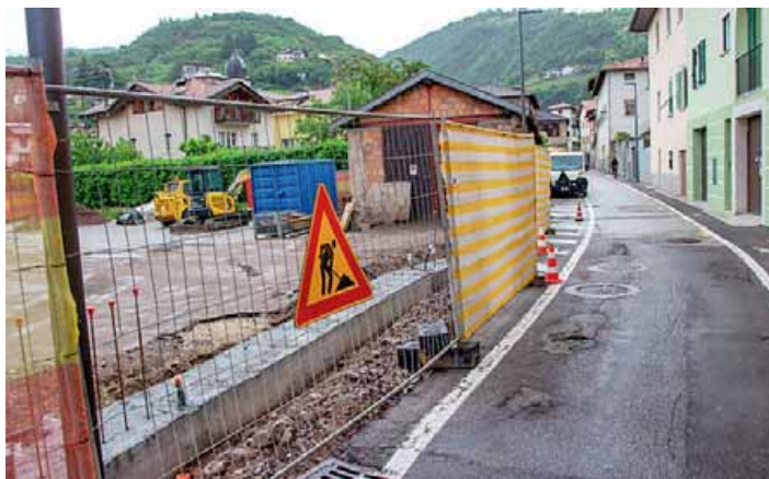
• L'accesso provvisorio alla scuola media sarà in via Orti
