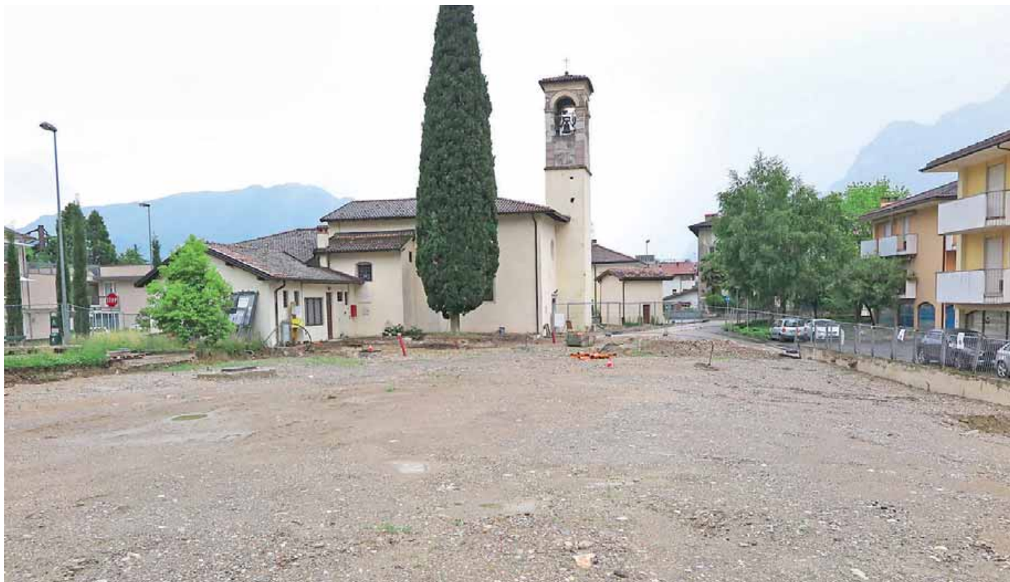
• Il cantiere dei lavori per la costruzione della nuova piazza davanti alla chiesa di San Marcello a Chiarano
