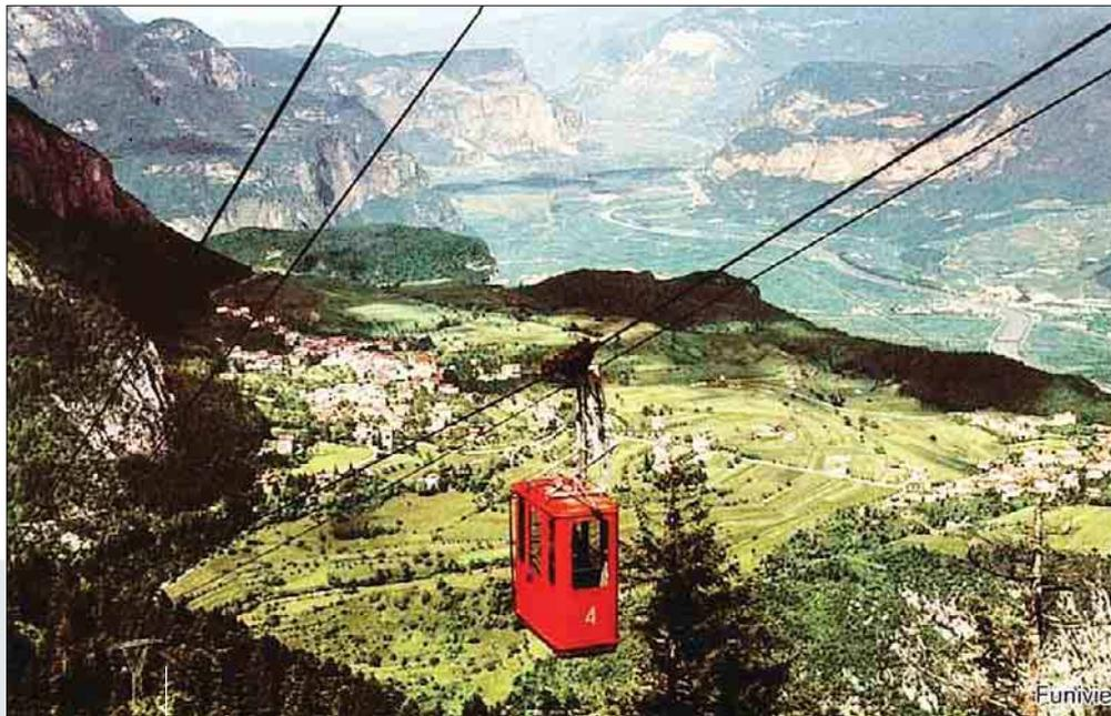
Una storica immagine della funivia. Il percorso passava per 12 piloni in cemento armato con una struttura ad "H", tutti dotati di una scala esterna. La distanza massima tra di loro raggiungeva i 451 metri. Sul dodicesimo era montato un anemometro: se il vento superava una velocità di 12 m/s, questo strumento mandava un segnale al macchinista
