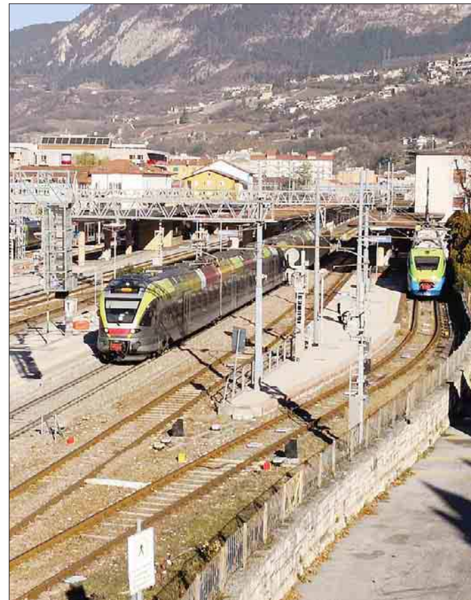
La stazione ferroviaria di Trento con la linea della Valsugana (a destra)
