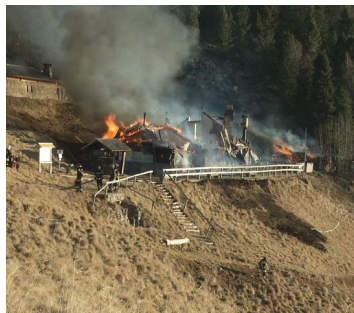
1. L'incendio del vecchio rifugio
