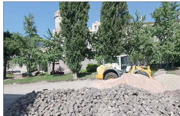
Il cantiere presente in piazza della Mostra (foto Panato)
