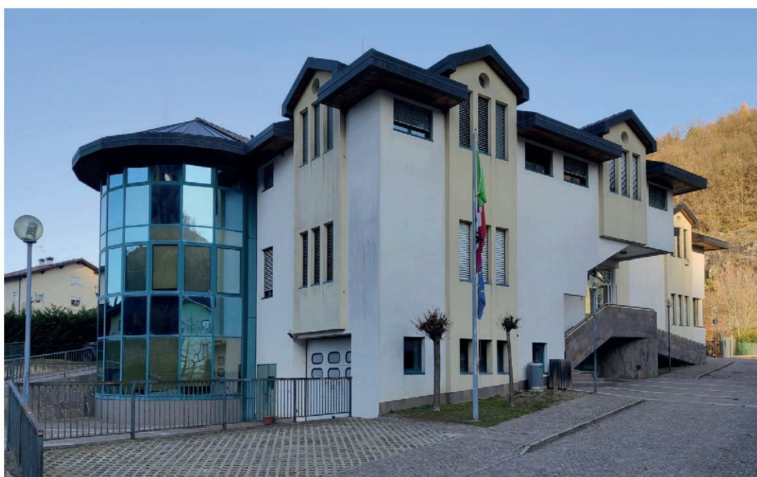
2. Fronte principale e facciata a valle
