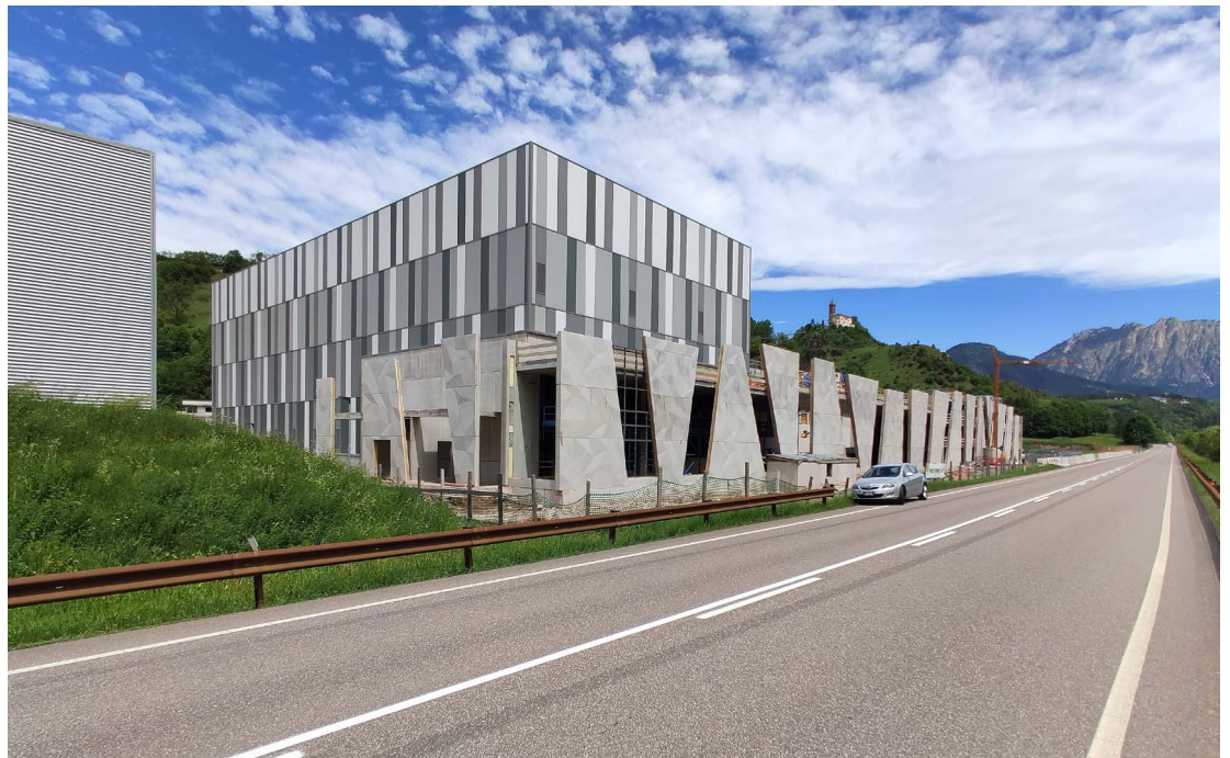
5. Il paesaggio attuale, con il nuovo stabilimento Felicetti in costruzione (maggio 2021)
