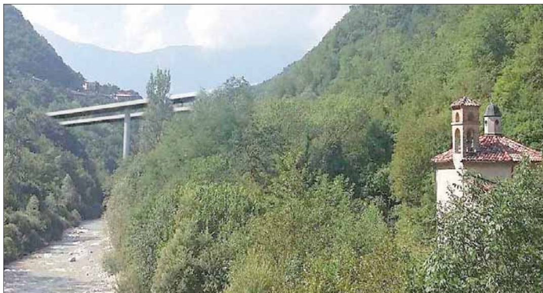
Il viadotto di Ca' Bianca. Il rendering, contenuto nel progetto realizzato dall'A4, simbolo dell'impatto ambientale dell'A31
