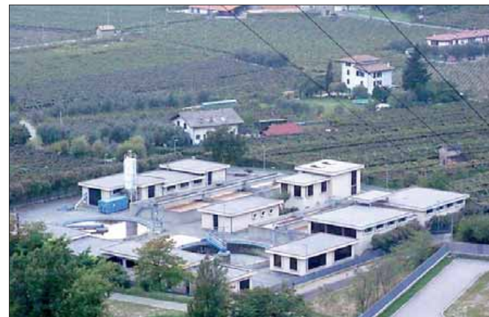
L'impianto di depurazione realizzato a fine anni Settanta al Linfano di Arco
