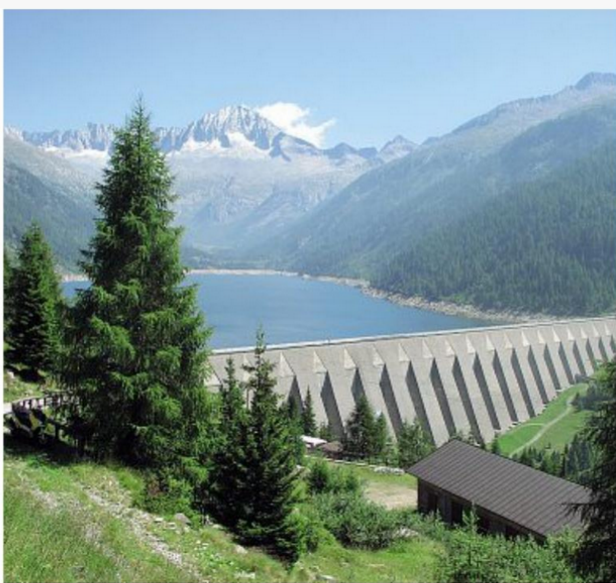
Sbarramento La diga di Malga Bissina che dà vita all'omonimo lago in Valdaone nelle Giudicarie
