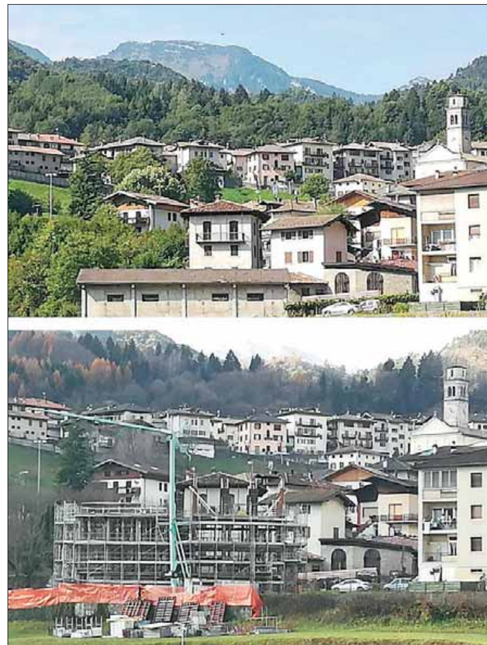
Sotto la casa in costruzione e sopra com'era prima; si nota il divario di altezza
