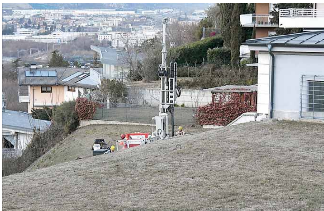
La trivella installata nella tarda mattinata di ieri tra via Spalliera e via Missioni Africane
