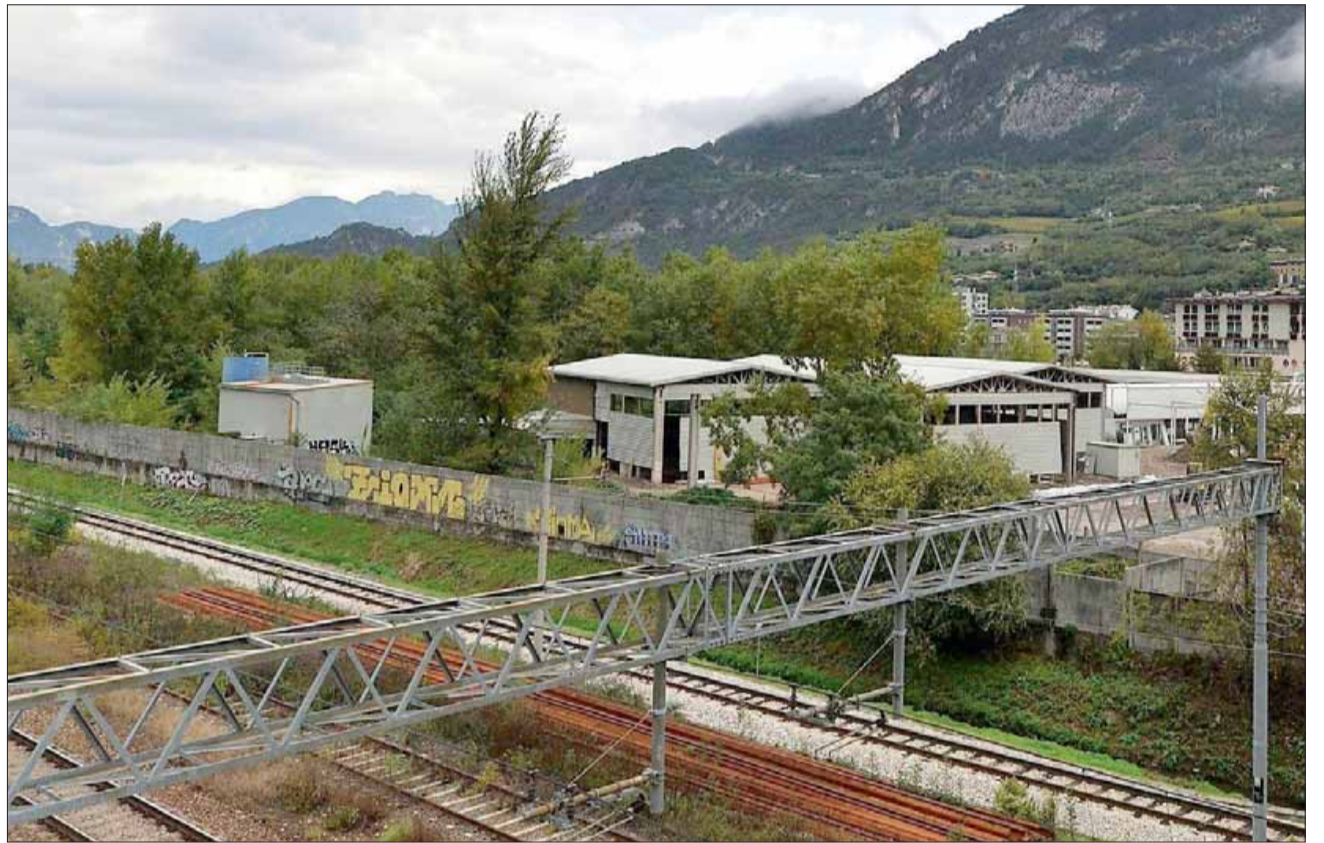
La ferrovia e la barriera idraulica installata nella parte sud dell'ex Carbochimica che dovrà essere "spenta" durante i lavori
