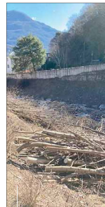
Nella foto a sinistra e qui sopra, due momenti della sistemazione del Rio Gola a Ravina
