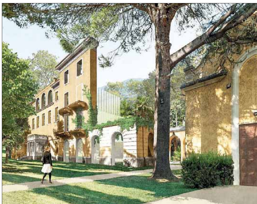
L'ex Colonia Miralago con il recupero della sola facciata, come indicato dal piano
