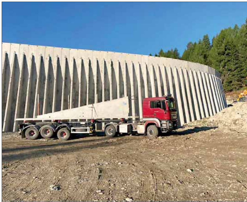
La costruzione del muro di contenimento del bacino da 180mila metri cubi
