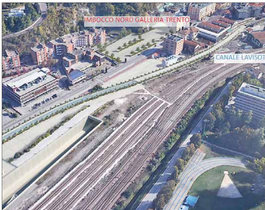
L'imbocco nord della galleria per il bypass ferroviario secondo il progetto di Italfer
