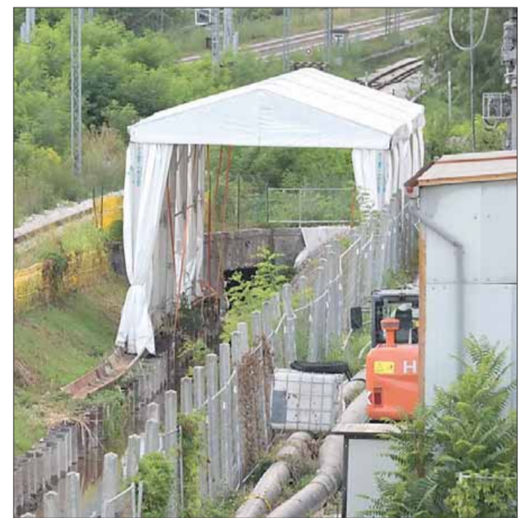
Il cantiere per la bonifica delle rogge, questa settimana fermo per ferie
