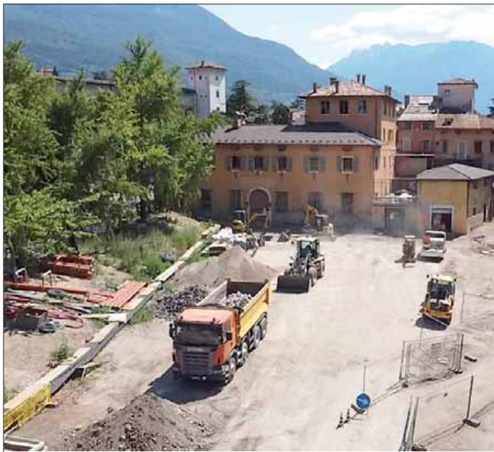
L'intervento in piazza Mostra era iniziato nel giugno 2021
