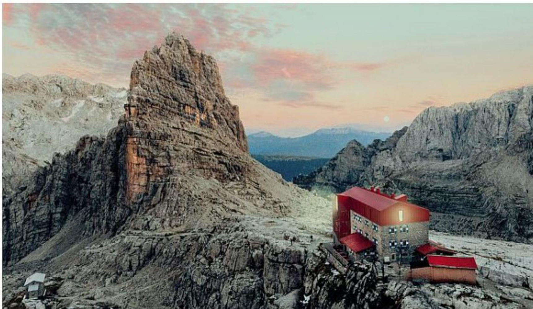
Posizione strategica Il rifugio Pedrotti alla Tosa, a pochi passi dalla Bocca di Brenta: nell'immagine la struttura dopo la ristrutturazione, con la nuova copertura rossa
