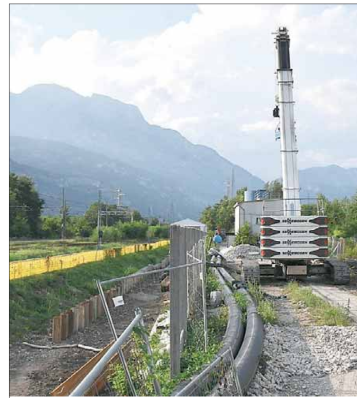
I lavori di sistemazione delle palancole e di iniezione della base in cemento
