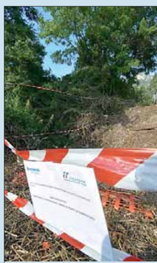
Cantiere pilota nella ex Sloi
