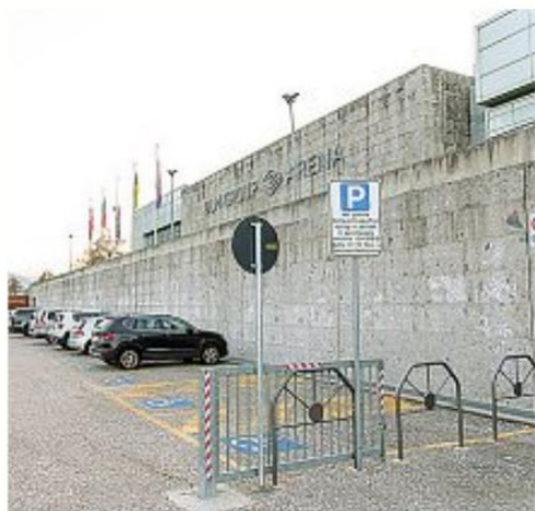
Trento sud La Blm Group Arena, dove si allenano e giocano le squadre di volley e basket della città Itas e Aquila, entrambe nel massimo campionato italiano. Il palazzetto è stato più volte soggetto a interventi di miglioramento
