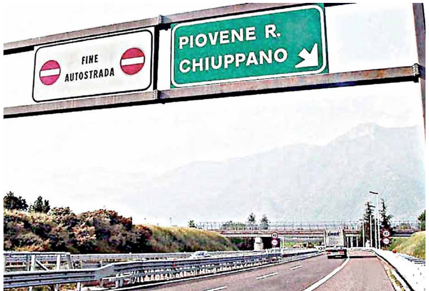
Il cartello di "Fine autostrada" a Piovene Rocchette: secondo Priante, più una sentenza definitiva che una indicazione stradale
