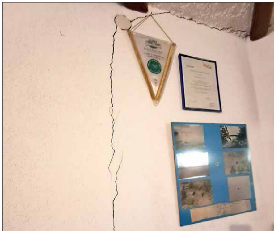
Sopra Nicolussi Castellan e Chiomento. A sinistra una delle crepe nella stube. Qui sotto una crepa riempita con schiuma: si vede che nel tempo si è allargata
