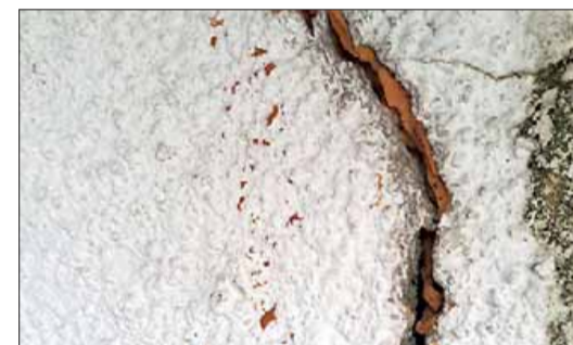
Sopra Nicolussi Castellan e Chiomento. A sinistra una delle crepe nella stube. Qui sotto una crepa riempita con schiuma: si vede che nel tempo si è allargata
