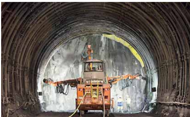
Tav, un'immagine dei lavori della Torino - Lione
