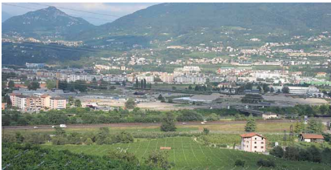
L'area di via al Desert dove era stato scelto di costruire il nuovo ospedale di Trento nel 2016
