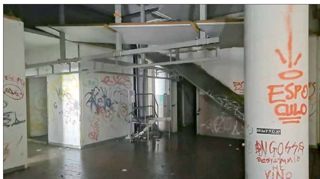
Uno degli edifici «storici» che segnano il degrado urbano: l'ex Macello di Mori Stazione (foto Gianni Cavagna)
