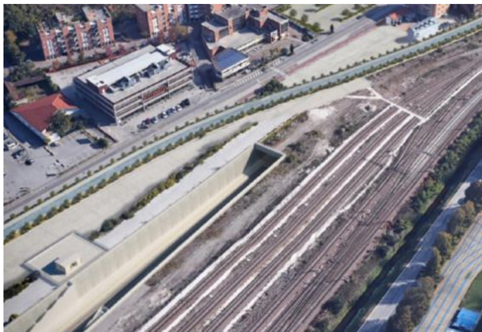
Fuori dal tunnel L'uscita della linea dalla galleria davanti al negozio Pittarello
