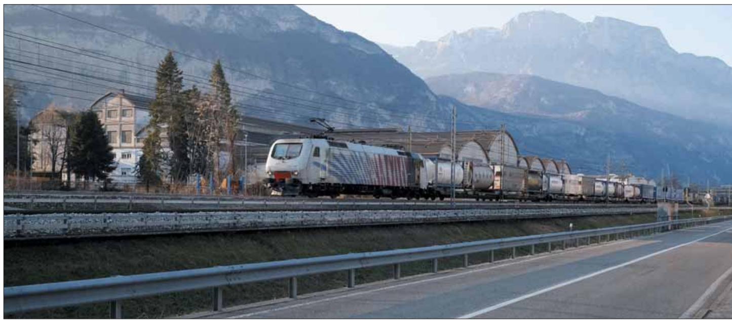
La ferrovia tra via Urterveger e via Maccani, dove sarà realizzato lo scavo in trincea per i nuovi binari, con i capannoni che in parte saranno abbattuti (foto Coser)
