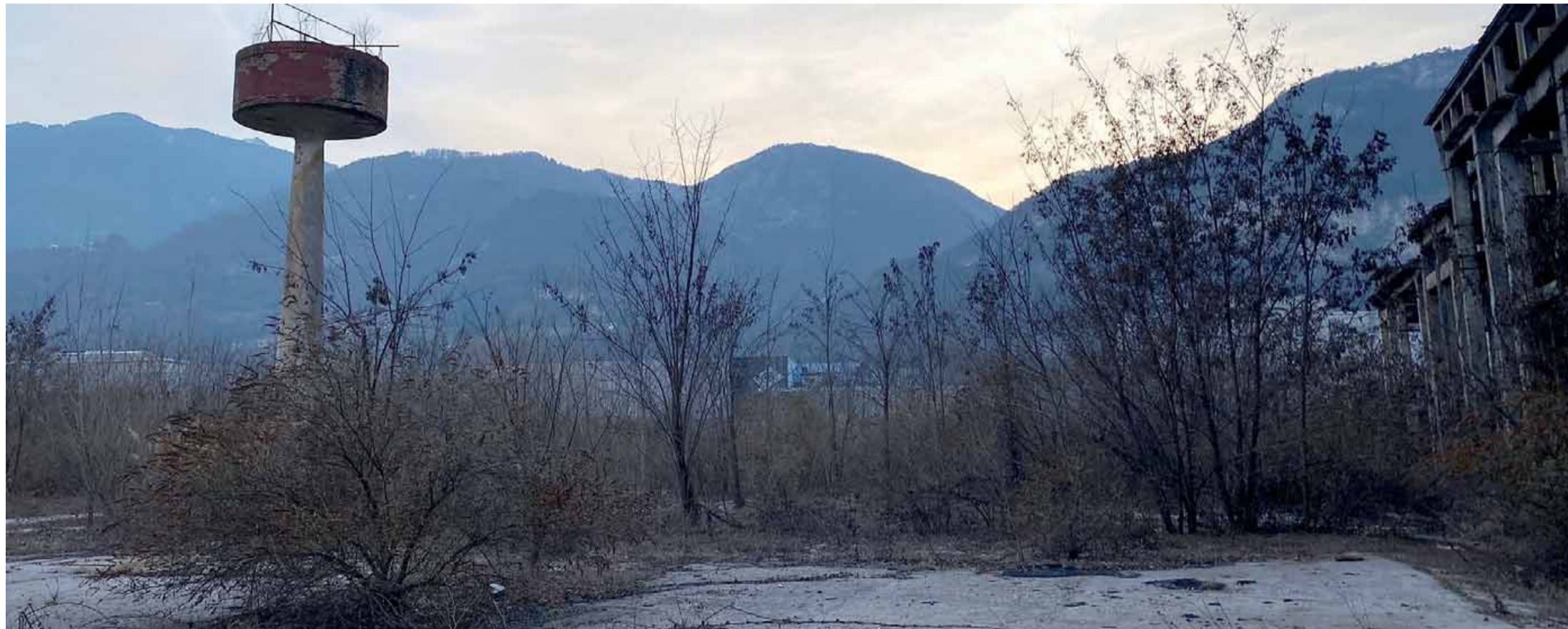
Un'immagine emblematica dell'area ex Sloi. Il tracciato ferroviario dovrebbe passare sui terreni contaminati da sostanze tossiche. Le aree ex Sloi ed ex Carbochimica sono il problema principale di Rfi, Provincia e Comune di Trento
