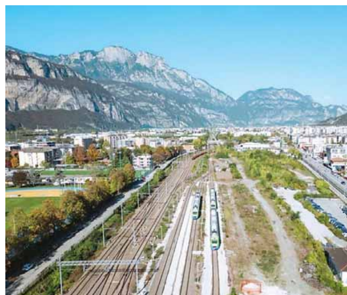
Si faranno le analisi sotto i binari, dove Italferr vuole scavare la trincea
