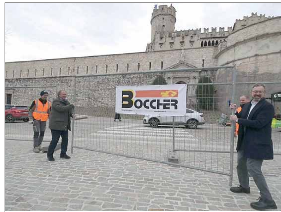
Ianeselli (a destra) e Andreatta spostano le recinzioni: il cantiere chiude, la piazza è riaperta
